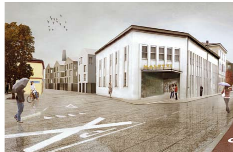
L'edificio recuperato e il nuovo intervento.
