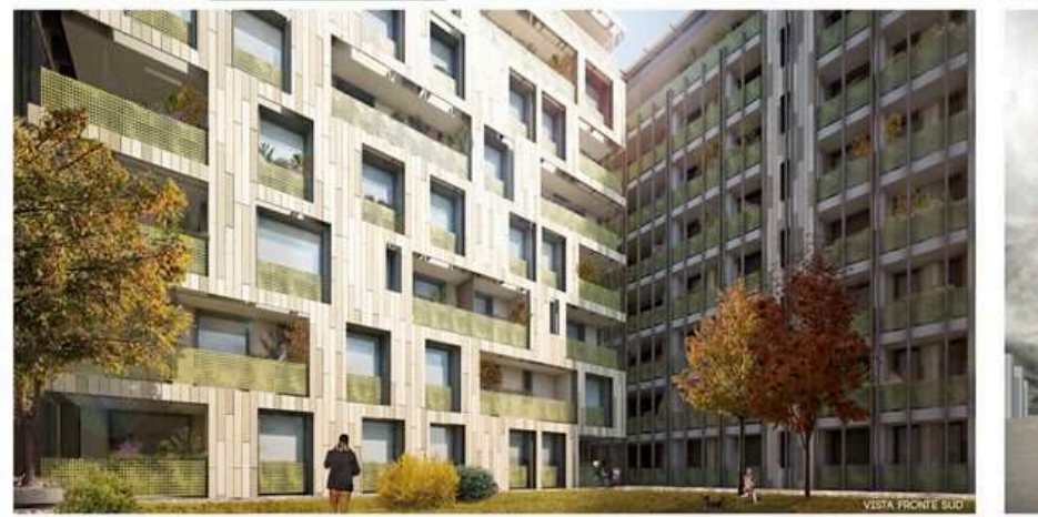
VISTA FRONTE SUD
