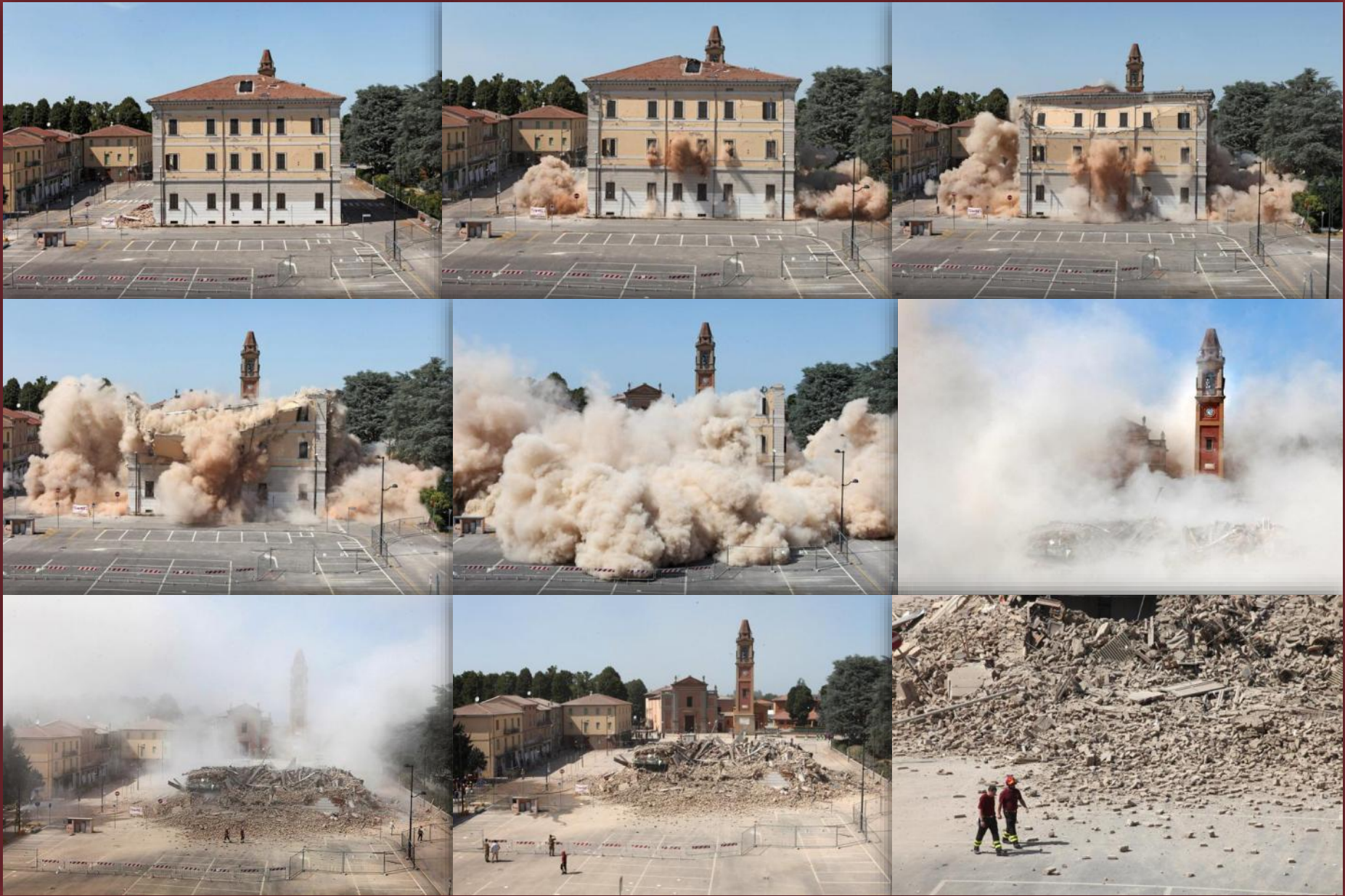
Sant'Agostino – Demolizione Municipio
